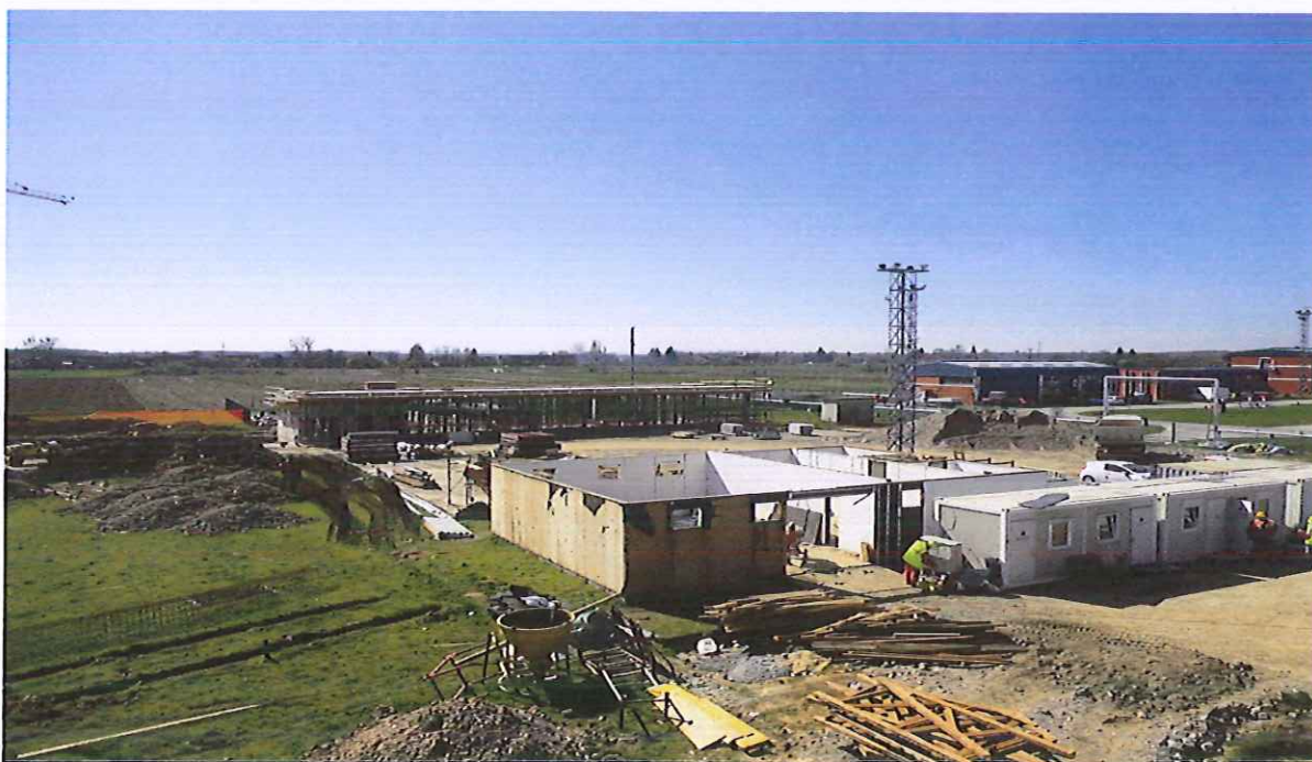
Slika 6. Radovi u tijeku-Upravna zgrada sa skladištem
