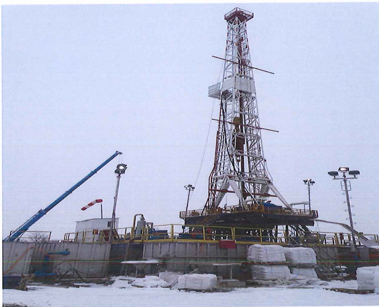
Slika 5. Bušaće postrojenje na Ok-63
